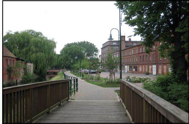
Rad-/Gehweg, Holzbrücke, Parkplatz
